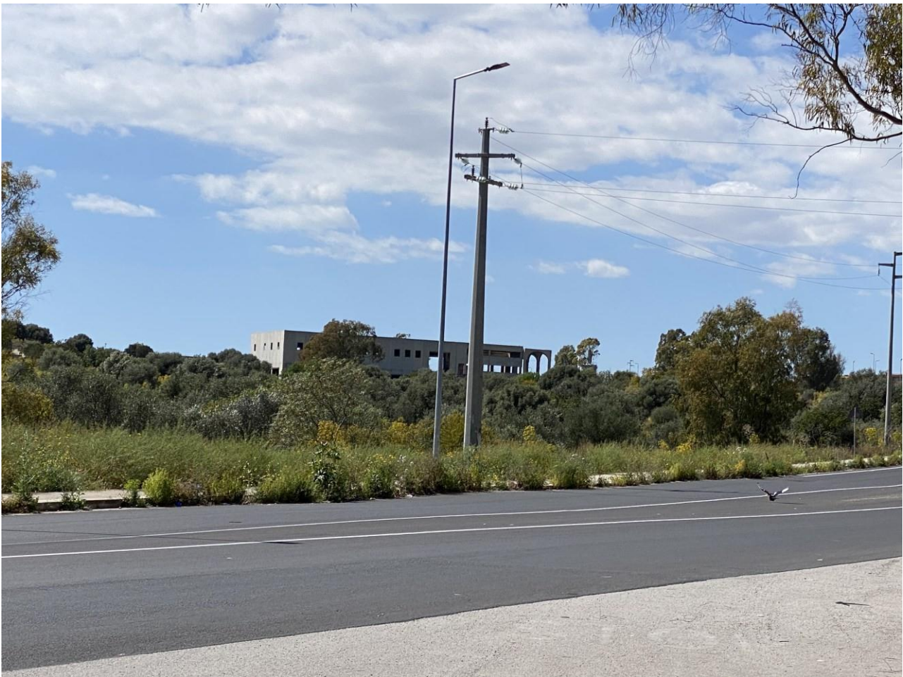
Vista del fabbricato dal viale delle Industrie
